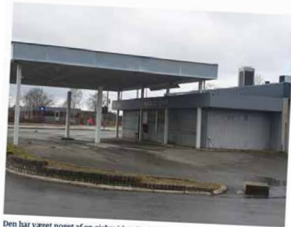
Den har været noget af en øjebæ i årevis, den nedlagte tankstation ved Hedeparken. Men nu er den formentlig snart fortid efter et retligt forlig.
