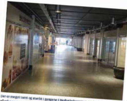
Der er meget tomt og mørkt i gangene i Hedegårdscenret. De håndlende efterlyser renoveringen og dens start på vej, lover Baldersbo.
