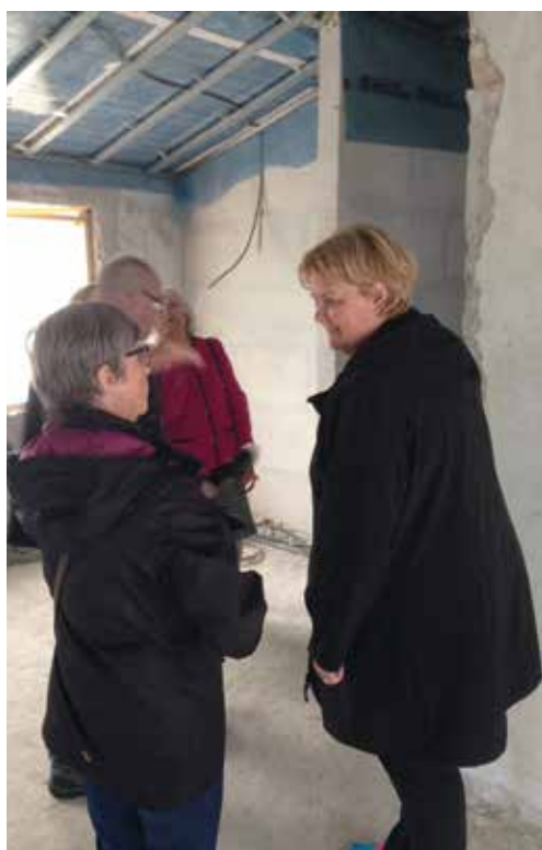
På billedet her kan du se, hvordan der så ud på Gl. Skolevej midt under renoveringen. På fotoet er det Marianne Wisén, der viser rundt.
