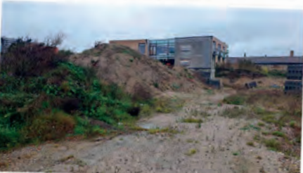
Der skal køres 2200 ton jord væk fra byggepladsen i løbet af de første uger af oktober. Foto: René Larsen
